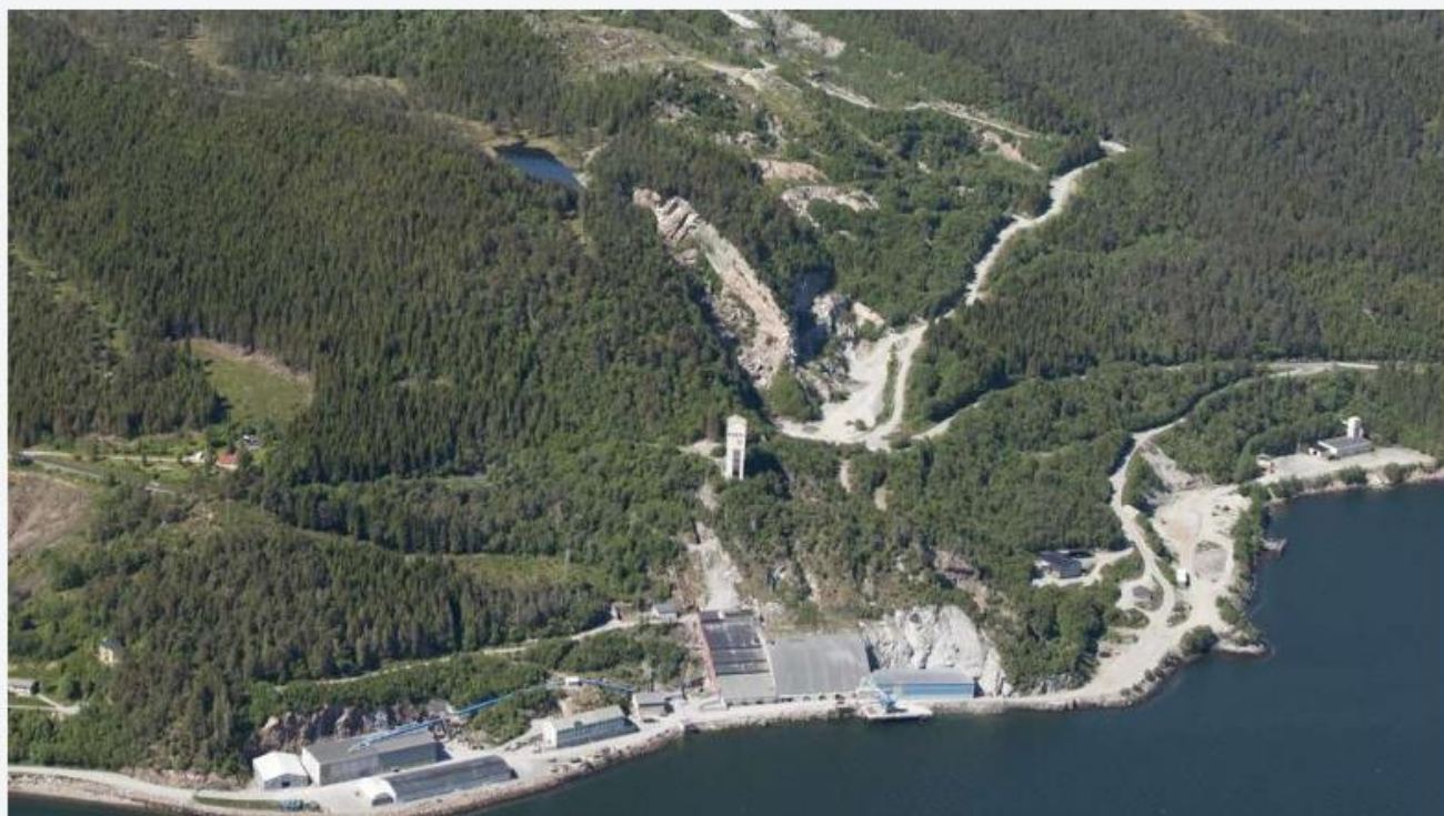
RAUDSAND: Mange har meining om Bergmesteren Raudsand sin plan om etablering av gjenvinningsanlegg og deponi for farleg avfall. FOTO: ØYVIND LEREN
